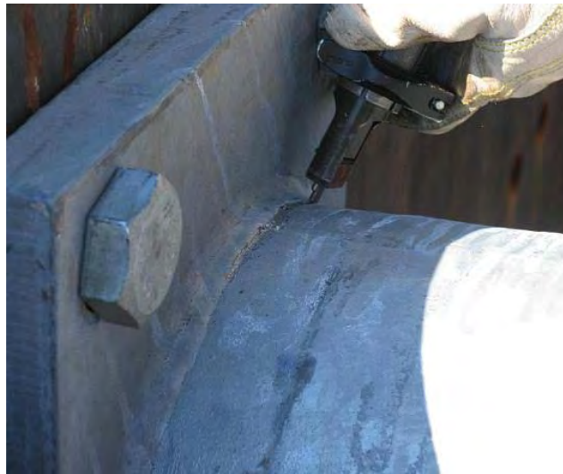
Figure 9 Application of UIT to a Mast Arm Weld Toe
