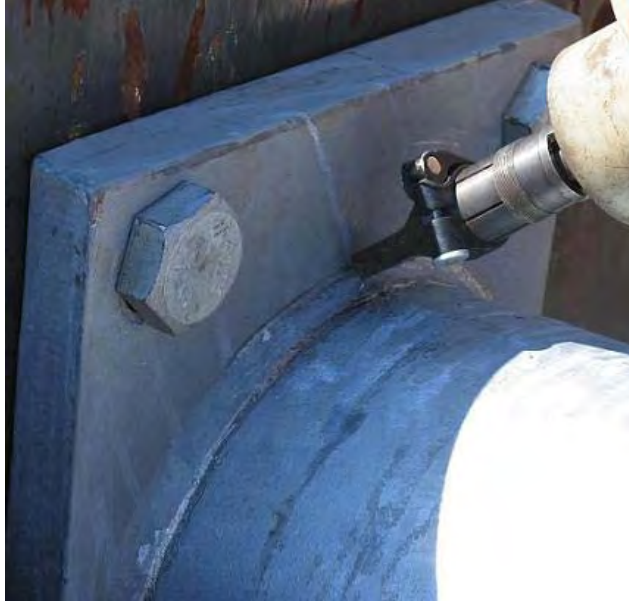
Figure 12 Application of UIT to Baseplate Weld Toe
