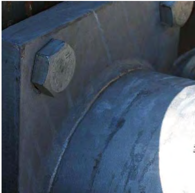
Figure 11 Completed Mast Arm Weld Toe UIT
